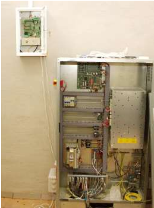
Рисунок 2 — Щит диспетчеризації (зліва) поряд з автоматикою ліфта
